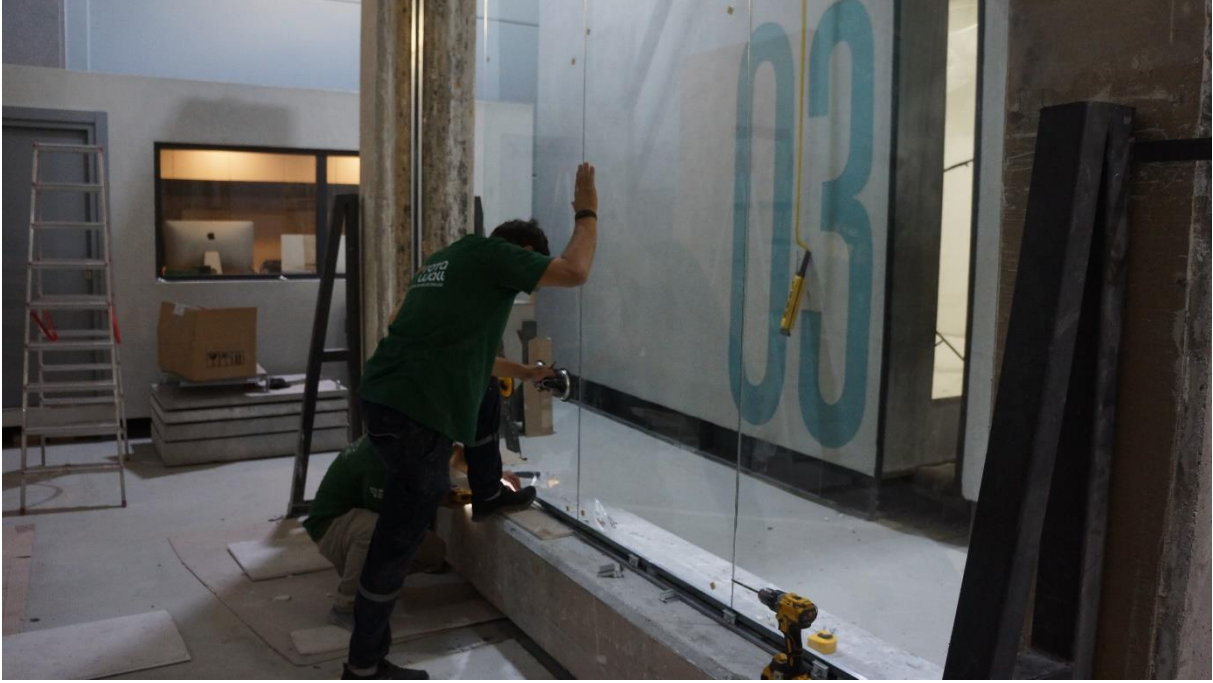
Şekil 3.5 Vera Sistem 10 mm Temperli Şeffaf Cam Montaj Detayı 3
