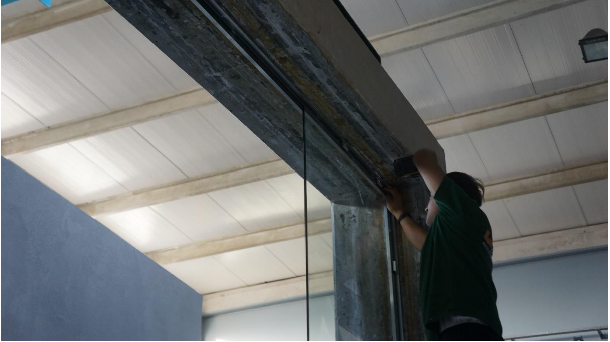
Şekil 3.4 Vera Sistem 10 mm Temperli Şeffaf Cam Montaj Detayı 2
