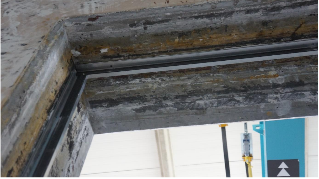
Şekil 3.3 Vera Sistem 10 mm Temperli Şeffaf Cam Montaj Detayı
