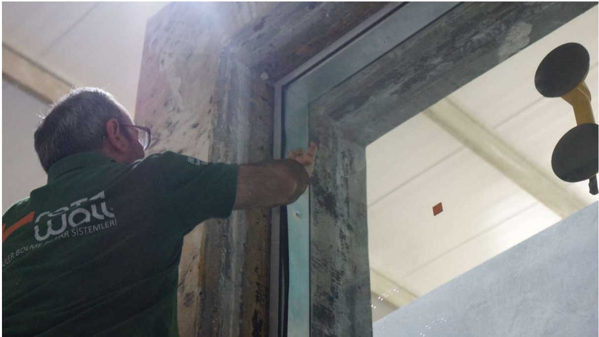
Şekil 3.6 Perspektika Sistem 10mm Temperli Cam/10mm Temperli Cam Montaj Detayı 4
